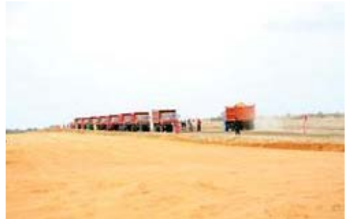
Obras para uma das pistas do novo aeroporto internacional de Luanda
